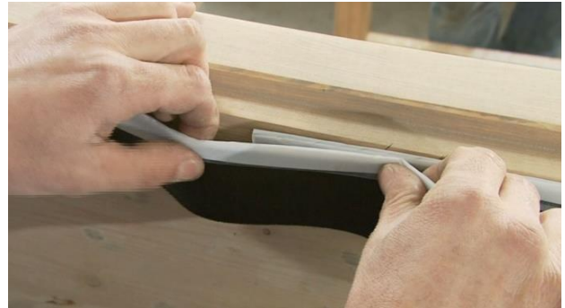
napojení pásky při ukončení
